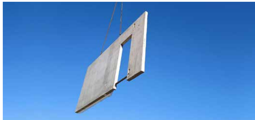
Ściana montowana na budowie za pomocą dźwigu
