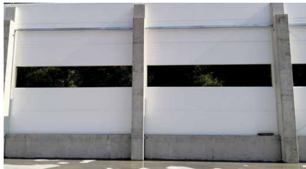
Podwaliny prefabrykowane zastosowane do budowy hali produkcyjnej
