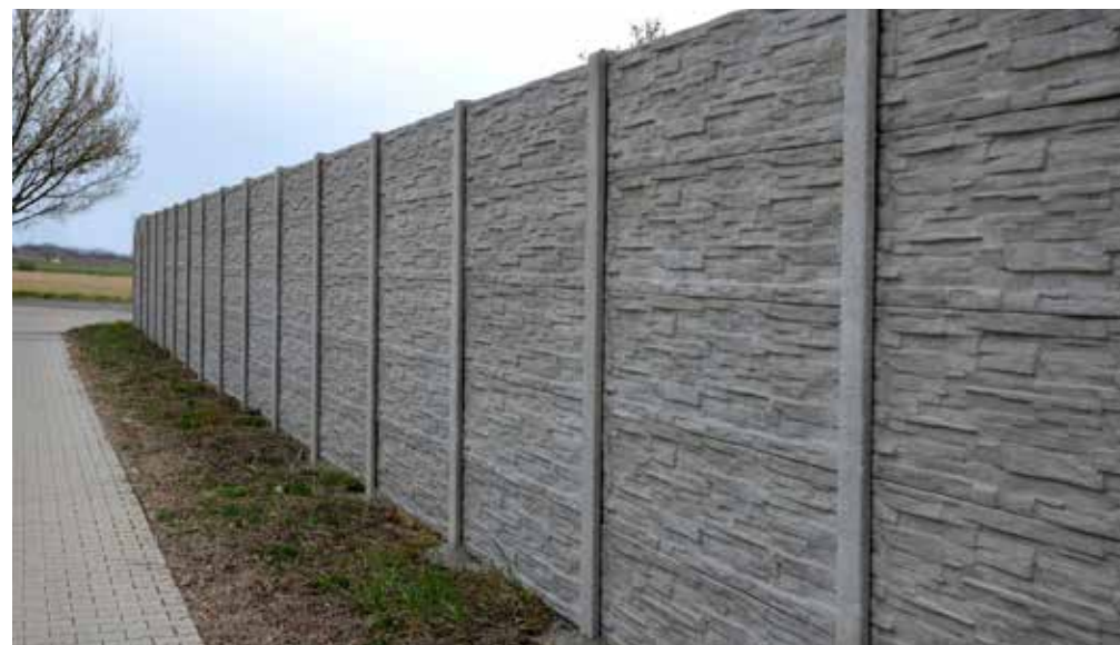
Posesja ogrodzona płotem betonowym
