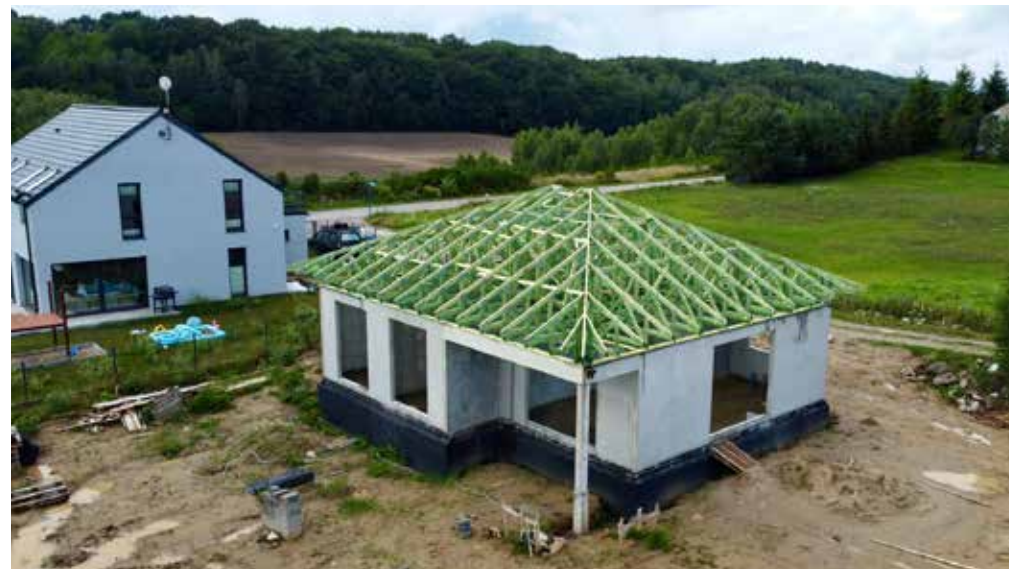
Budowa domu jednorodzinnego ze ścian prefabrykowanych
