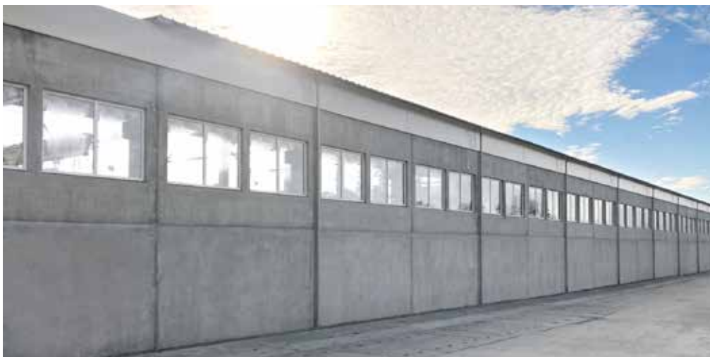
Hala produkcyjna zbudowana ze ścian trójwarstwowych
