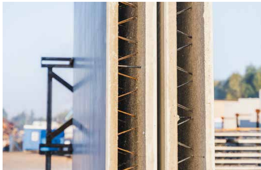
Przekrój ściany zespolonej
