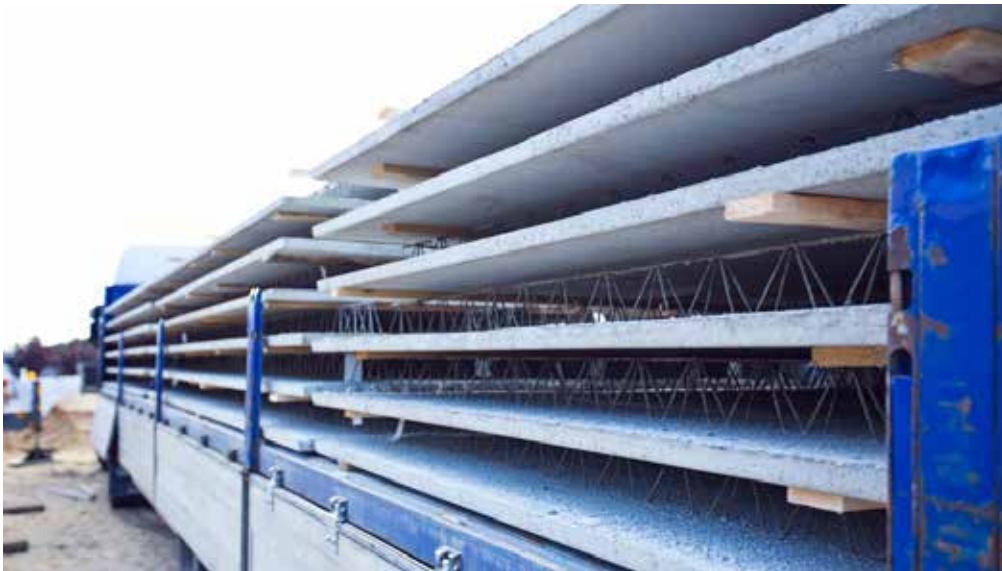
Transport płyt stropowych
