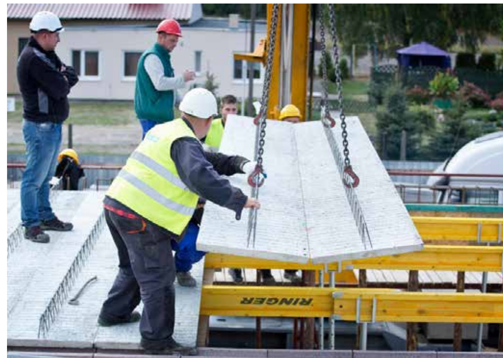
Montaż stropu Vector
