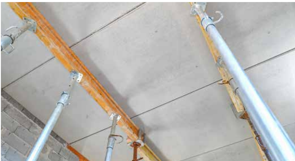
Strop filigranowy jest gładki i nie wymaga tynkowania
