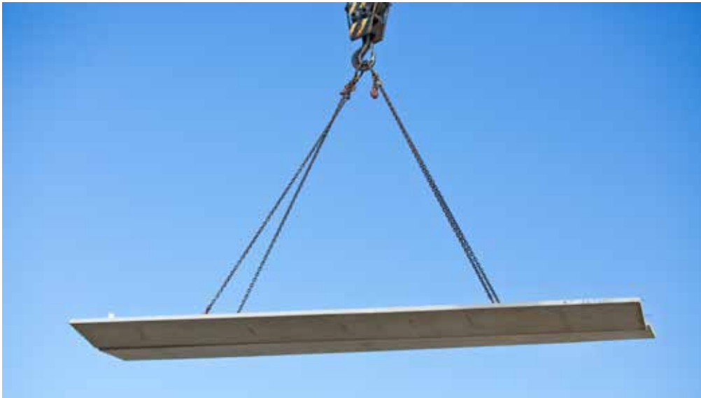
Szybki montaż płyt za pomocą dźwigu HDS
