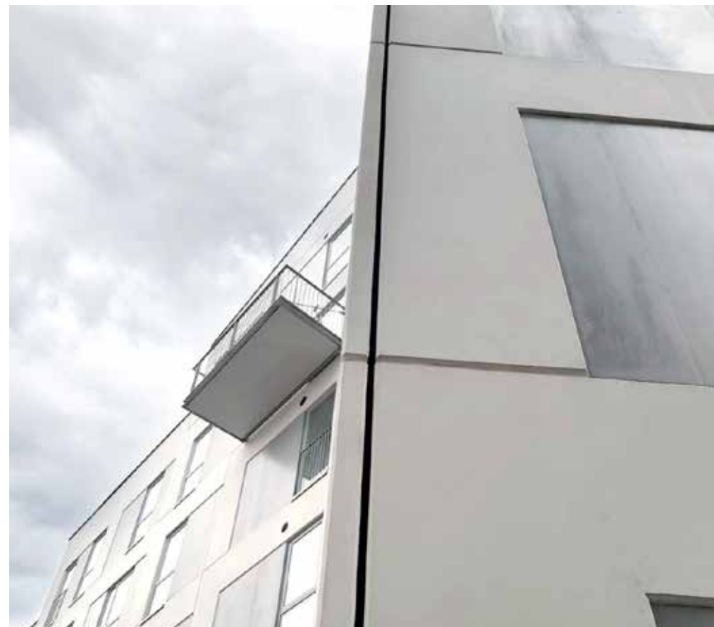
Budynek postawiony ze ścian prefabrykowanych trójwarstwowych
