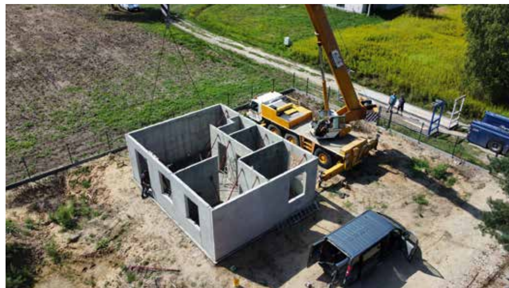
Montaż ścian prefabrykowanych za pomocą dźwigu
