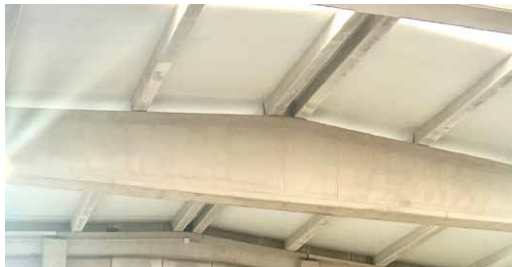
Dźwigary dachowe zastosowane w konstrukcji hali produkcyjnej
