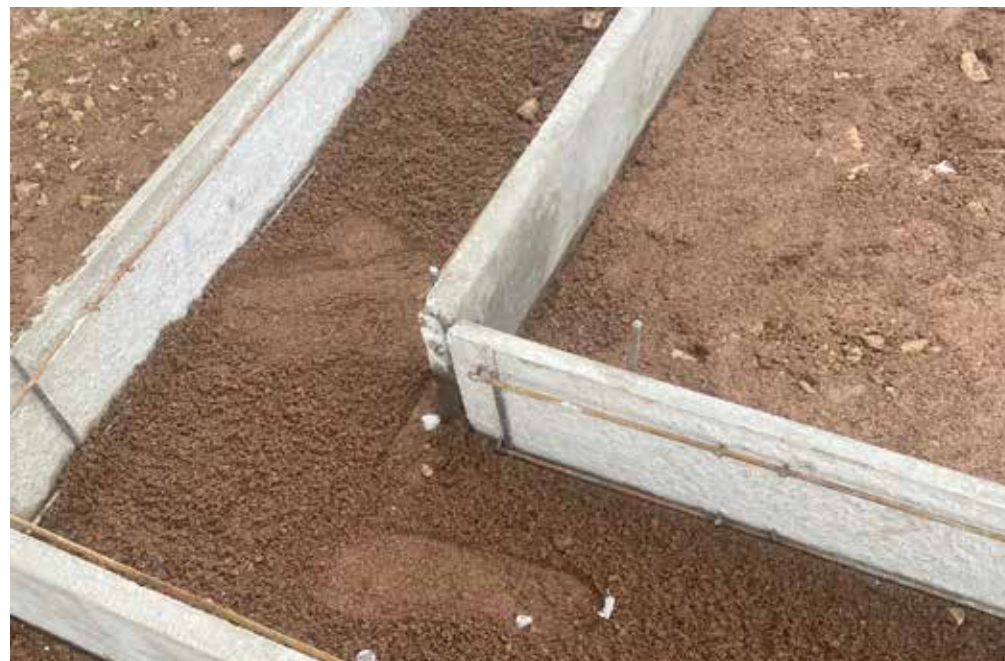
Przykład zastosowania betonowych desek szalunkowych do wykonania fundamentu
