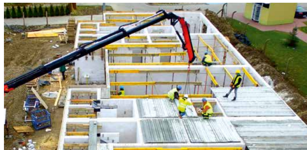
Montaż stropu filigranowego
