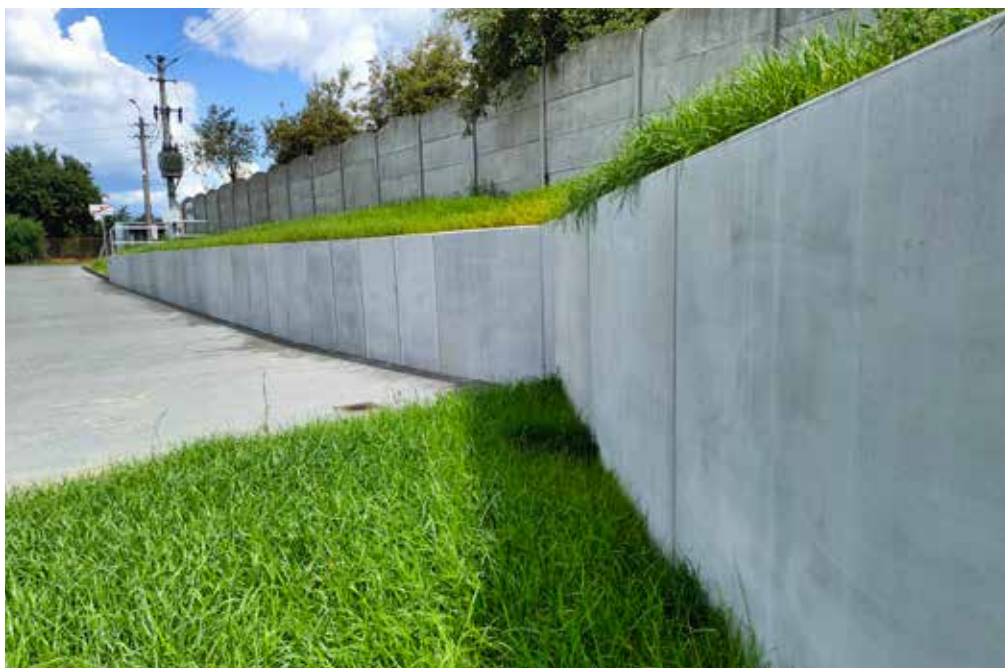
Mur oporowy jako zabezpieczenie nierówności terenu na parkingu
