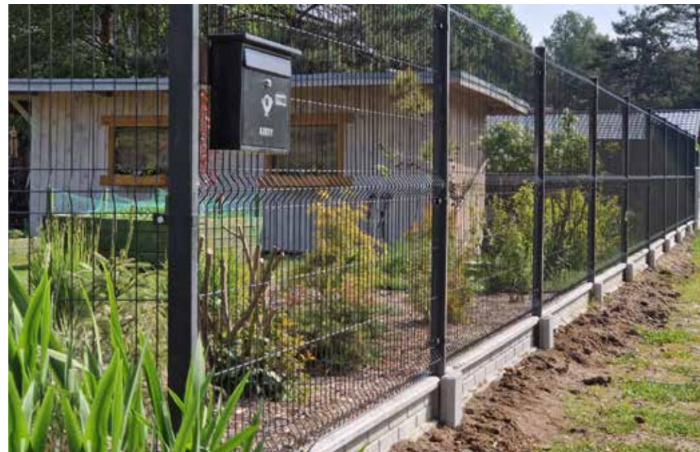
Ogrodzenie postawione z wykorzystaniem podmurówek prefabrykowanych
