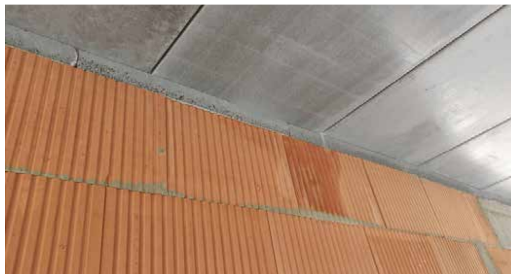
Zastosowanie betonowych podkładek dystansowych pod stropem filigranowym
