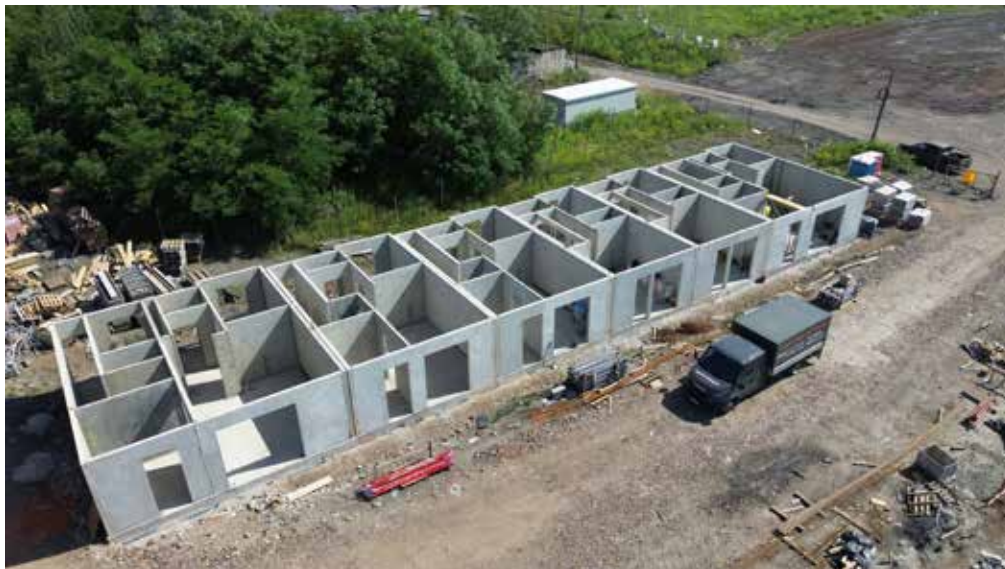
Budynek szeregowy stawiany ze ścian prefabrykowanych
