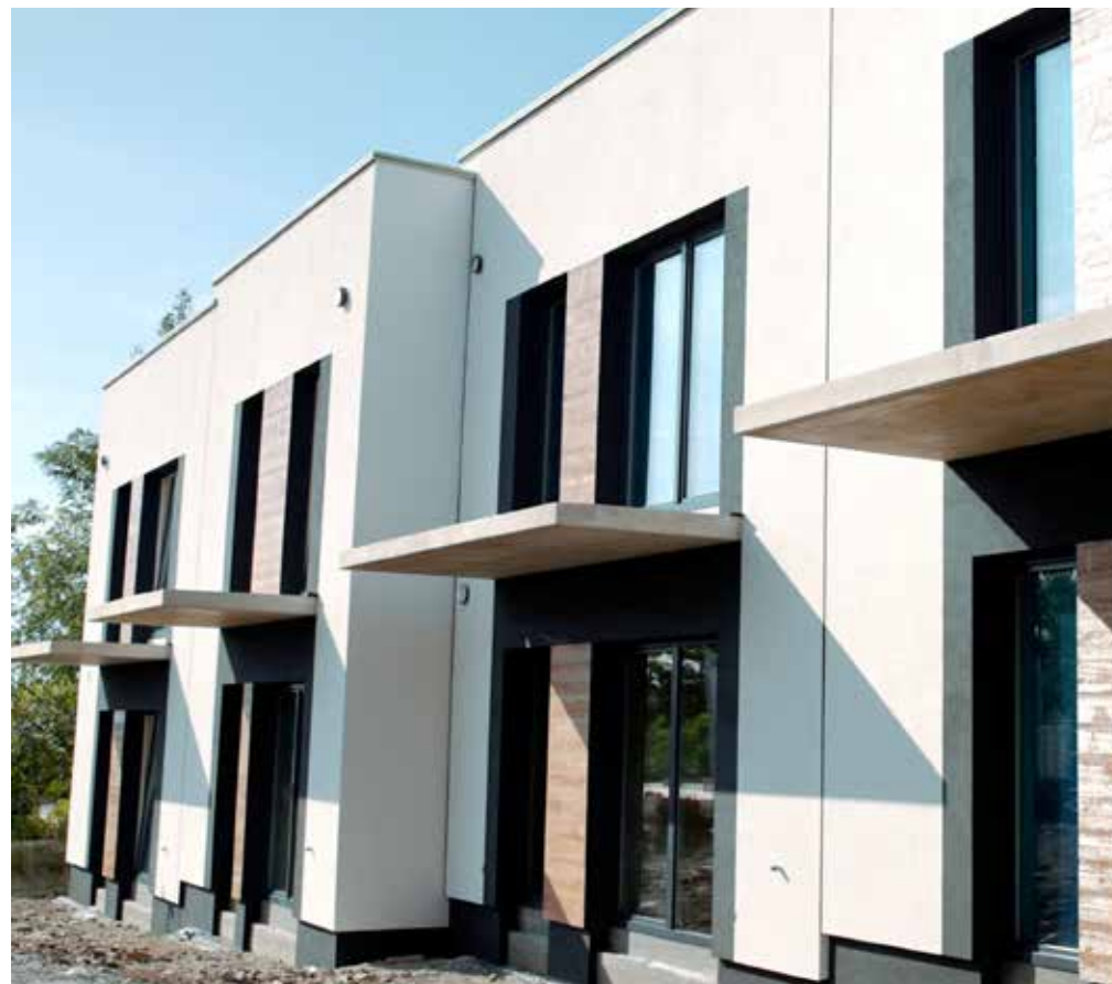
Zamontowane balkony prefabrykowane z łącznikiem termoizolacyjnym
